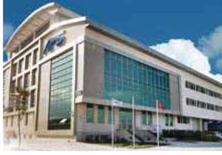
AFS Boru Fabrikası - Ankara
