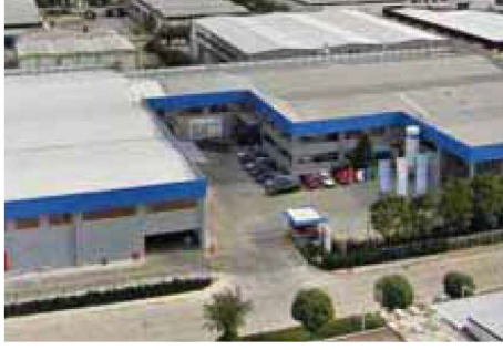
PFW Havacılık Fabrikası - İzmir
