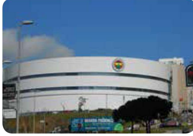
Fenerbahçe Arena Park İstanbul
