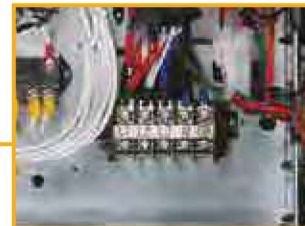
Dış ünite güç besleme terminal bloğu
